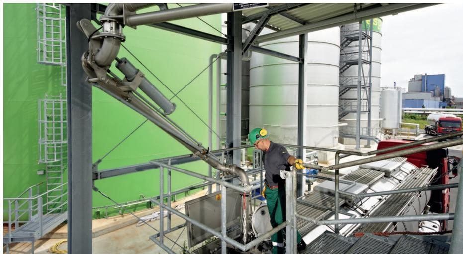
Befüllung eines Tanklastzuges
