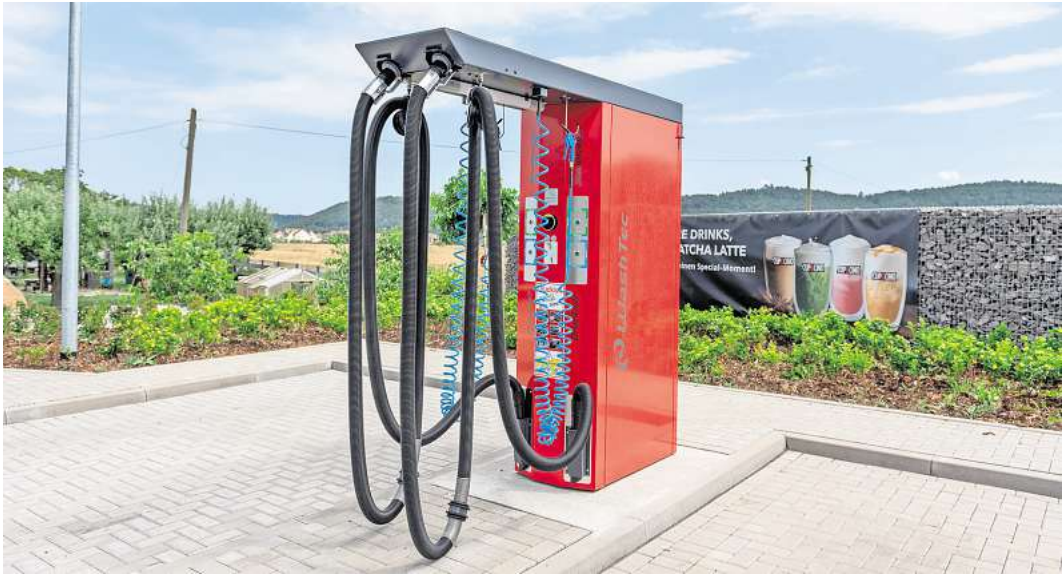
Den Kundinnen und Kunden des neuen Mobility Hubs stehen neben den Tankmöglichkeiten auch E-Ladesäulen und Reinigungsplätze für den Fahrzeuginnenraum zur Verfügung.
